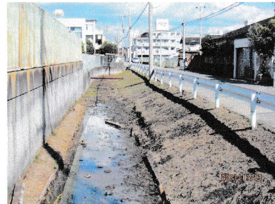
・清掃作業完了後の状況(11月13日)
